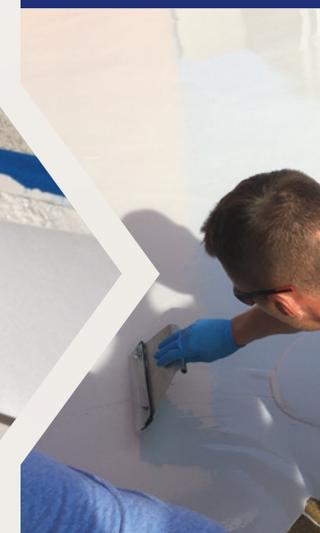
Une couche de résine sur le support des infiltrations
