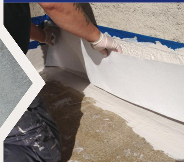
Les voiles de renfort permettent d'assurer la tenue des résines qui assurent l'étanchéité.
